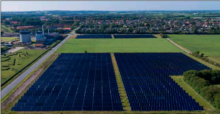
15.300 m 2 (10,7 MW th ) Solarthermie Anlage Løgumkloster
