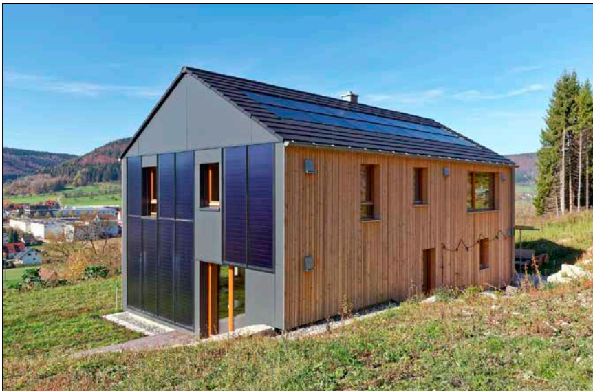
Bild 1: Nachhaltiges Baukonzept: Holzständerbauweise mit Strohballen als Wärmedämmung sowie Solarthermie und Photovoltaik. Ausgezeichnet mit dem ersten Platz im Holzbau-Plus-Wettbewerb des Bundesministeriums für Ernährung und Landwirtschaft.
