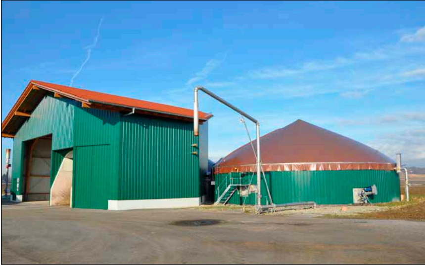
Bild 1: Biogasanlage in Niederbayern
