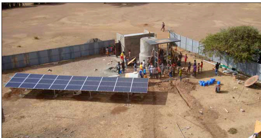
Bild 3: Die Solaranlage für einen Trinkwasserbrunnen für das kleine Dorf Jahwe Bofa
