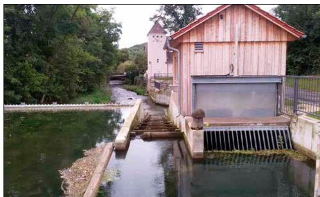
Bild 4: Die Anlage vom Oberlauf aus gesehen: rechts das Betriebsgebäude mit dem Rechen und dem Schieber, in der Mitte der Fischpass und links die Wehrklappe.
