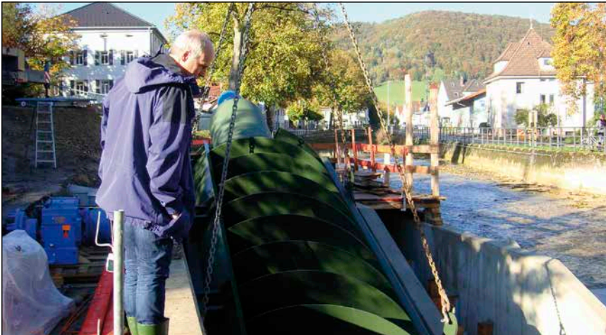
Bild 1: Deggingen, im Jahr 2014: Beim Einbau der Wasserkraftschnecke war Millimeterarbeit gefragt. Sie hat einen Durchmesser von 2,30 m und eine Länge von 11 m.
