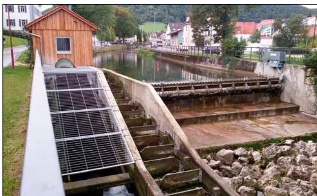
Bild 3: Perfekt gelöst: Wegen der begrenzten Platzverhältnisse wurden an der Fils die Wasserkraftschnecke, der Fischpass und die Wehrklappe parallel nebeneinander angeordnet.
