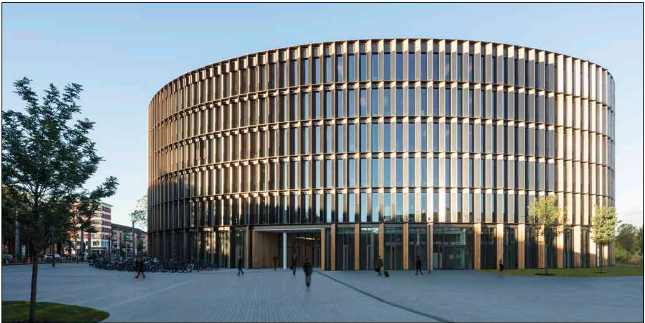
Bild 1: Die Fassade des neuen Freiburger Verwaltungszentrums mit integrierten Solarmodulen
