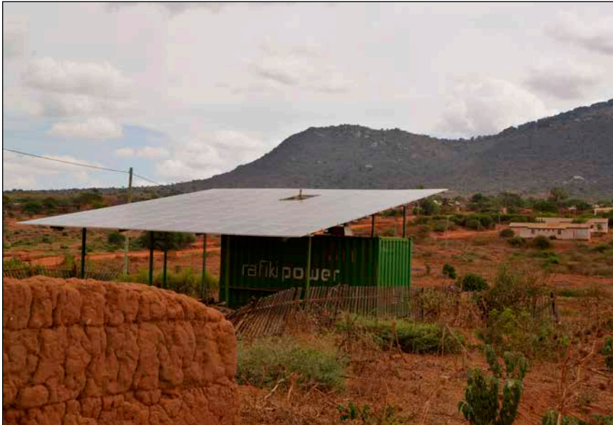
Bild 1: Die Rafiki-Power Lösung ist ein Modulsystem mit Technik aus Deutschland. Dabei wird der Container vormontiert geliefert.
