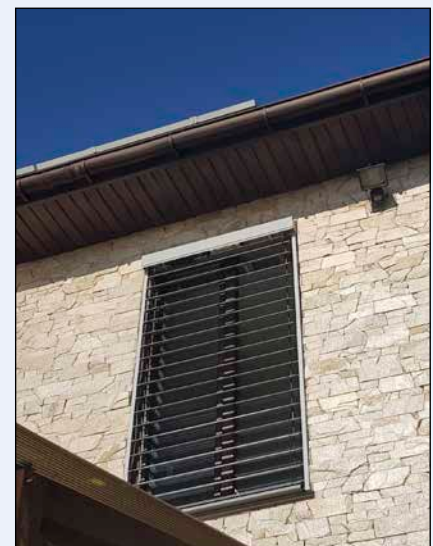
Bild 2: Fenster mit SolarGaps-Solarjalousien
