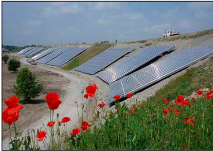
Solare Nahwärme Crailsheim
