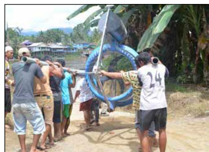
Bild 6: Installation einer Smart-Mono-float-Turbine in Indonesien
