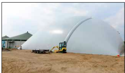
Bild 4: Neuer Gasspeicher auf der Biogasanlage der Stadtwerke Grevesmühlen
