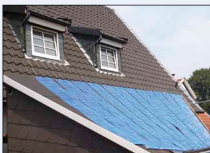
Bild 8 und 9: Suncracker hinter Dachziegel offen und geschlossen
