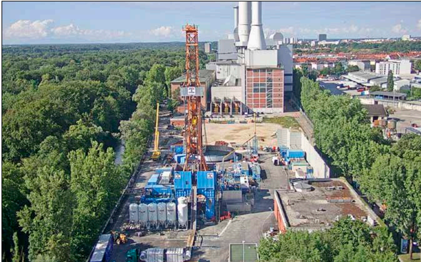
Bild 1: Im September haben die Stadtwerke München die fünfte von sechs Bohrungen für die Geothermieanlage am Heizkraftwerk Süd niedergebracht. Die Leistungstests an den ersten vier Bohrungen erbrachten vielversprechende Ergebnisse: Die Temperatur ist deutlich höher als erwartet. Mitte 2020 sollen die Arbeiten an allen Bohrlöchern abgeschlossen sein. In der Heizsaison 2020/21 soll die Anlage ans Netz gehen.
