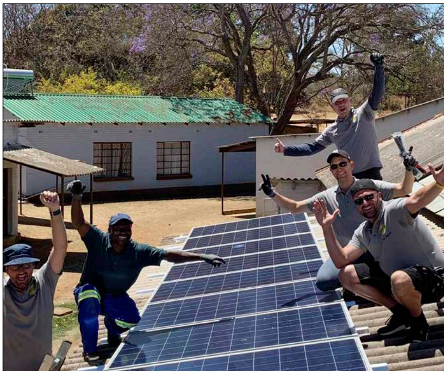
Bild 2: Das stolze Installationsteam auf dem Dach
