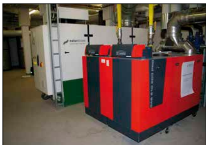
Bild 2: Biomethan-Konsumenten! 100 % für das BHKW (hinterhalb) und 10 % für den Gaskessel im Vordergrund.
