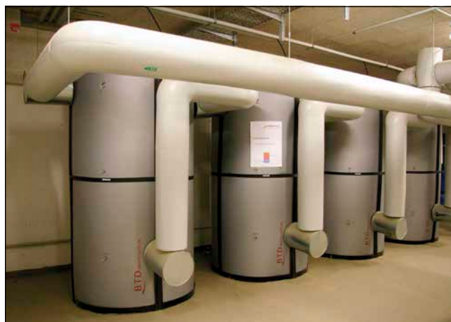
Bild 4: 4-teilig, 12.000 Liter fassend – mit dem Pufferspeicher-System können einerseits Wärmelast-Spitzen bedient werden, andererseits muss das BHKW in Schwachlastzeiten nicht so oft takten.
