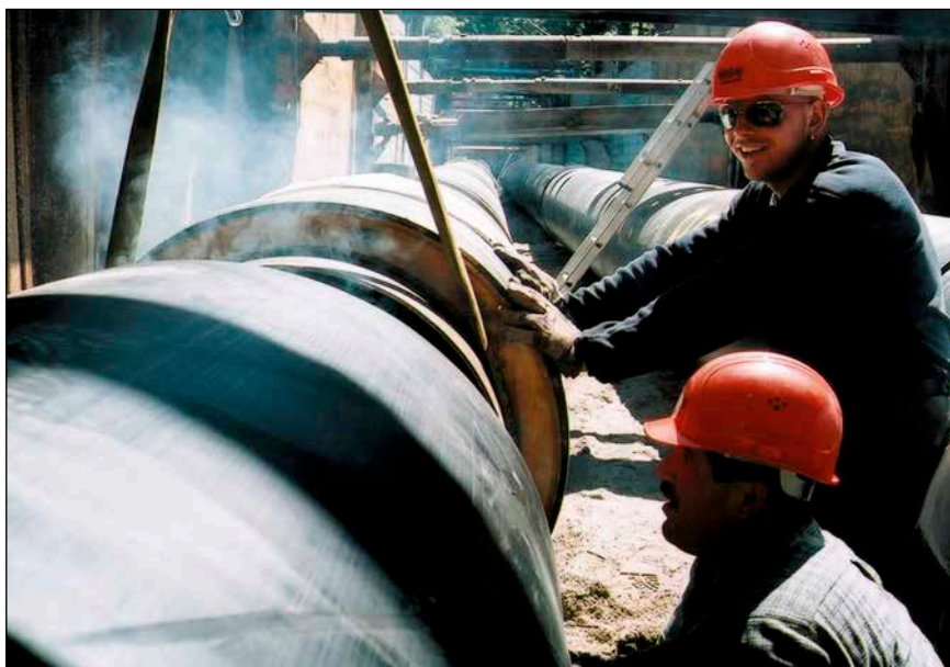
Bild 2: München baut sein Fernwärmenetz aus. Künftig soll immer mehr Erdwärme durch die Rohre fließen.
