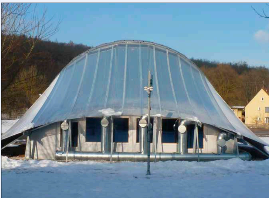
Bild 5: Das Testgebäude mit flexiblen Solarkollektoren auf dem Dach und den TAO-Speichern im Inneren
