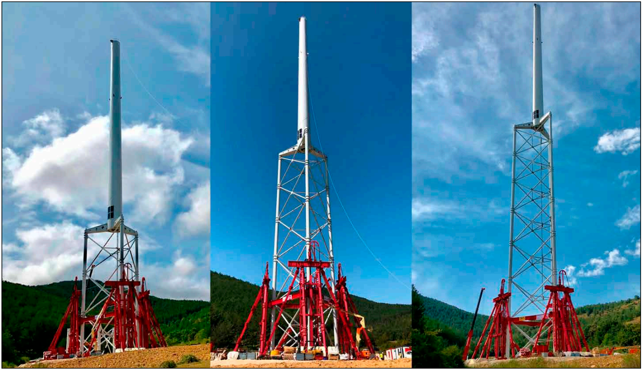
Bild 2: Die Turmkonstruktionen der spanischen Firma Nabrawind werden quasi von oben nach unten gebaut, indem immer wieder neue Segmente unter die schon fertige Konstruktion geschoben werden.
