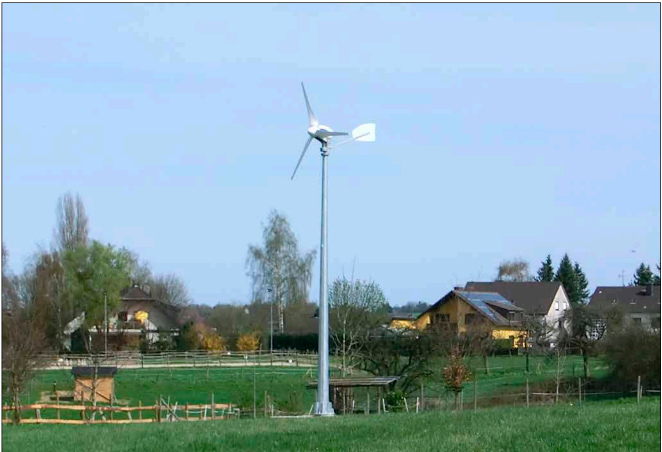
Bild 1: Kleinwindanlage mit 1,5 kW Leistung
