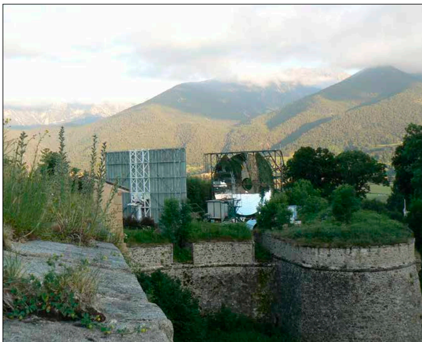
Bild 3: Die Spiegel des Sonnenofens stehen auf der Stadtmauer der historischen Zitadelle von Mont Louis. Rechts der Paraboloid, links der plane Heliostat. In dem grauen Container vor dem Paraboloid befindet sich der Schmelzofen.
