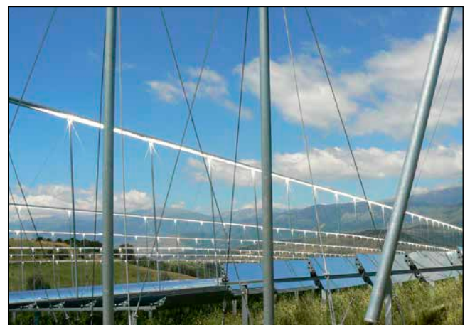
Bild 6: eLLO-Fresnel-Solarkraftwerk bei Llo. Hell erleuchtet: die festen Empfängerrohre durch die Wasser zirkuliert, welches in Dampf umgewandelt wird.
