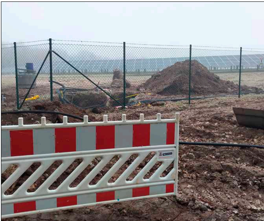
Bild 1: Baustelle PV-Gemeinschaftsanlage nahe Coburg
