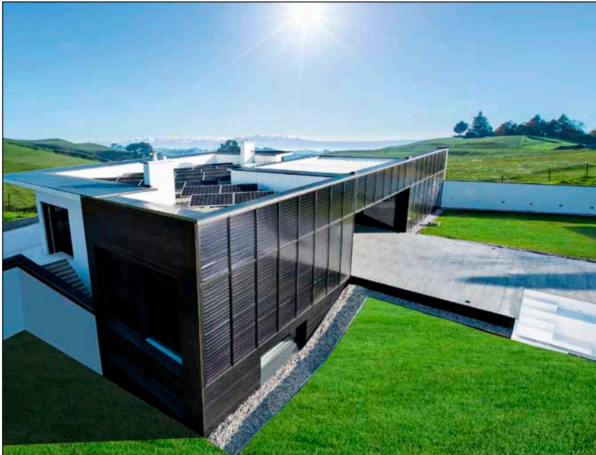
Bild 1: Ein Pellets-Stirling im Keller und Solarmodule auf dem Dach liefern den Strom für das Sonnenhaus im oberösterreichischen Schwertberg.
