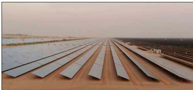
Bild 2: Wegen der niedrigen Stromgestehungskosten dank der klimatischen Bedingungen haben Photovoltaikanlagen einen erheblichen Anteil im MENA-Strommix.
