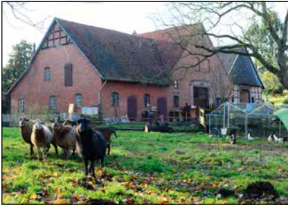
Bild 1: Außenansicht des Schaumburger Fachwerkhauses, in dem die Familie Feike einen Grundofen installiert haben
