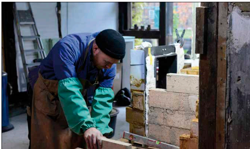
Bild 2: Ofenbauer Vadim Berezin bei sensiblen Maurerarbeiten am Grundofen
