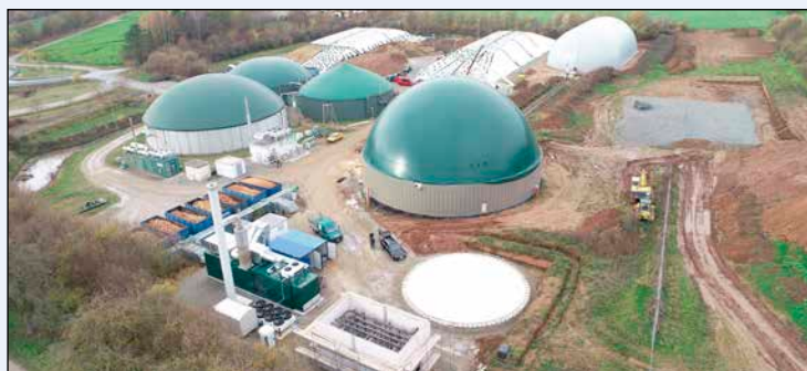
Bild 5: Das regenerative Speicherkraftwerk der Bioenergie Wanfried GmbH & Co. KG.; hinten grau: externer Gasspeicher; vorn neues Flex- BHKW. Wärmespeicher im Bau
