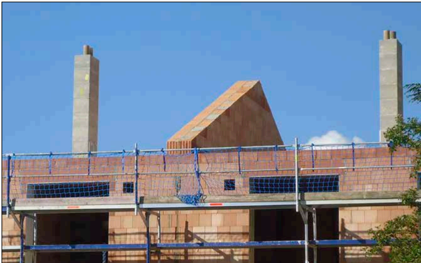
Bild 1: Brandwand im Geschosswohnungsbau (vor Aufrichten des Dachstuhles)
