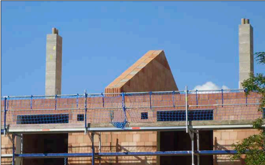
Bild 1: Brandwand im Geschosswohnungsbau (vor Aufrichten des Dachstuhles)
