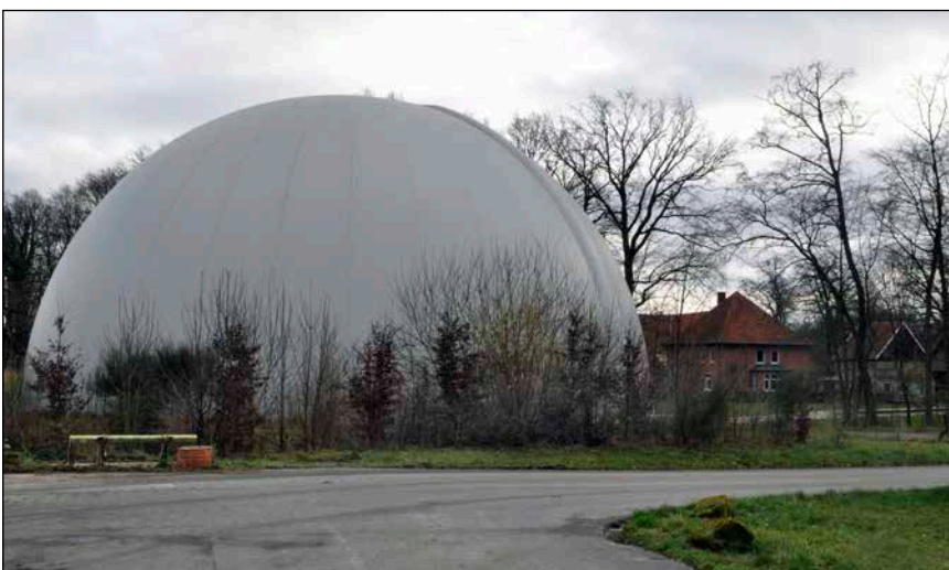
Bild 2: Externer Gas-Pufferspeicher
