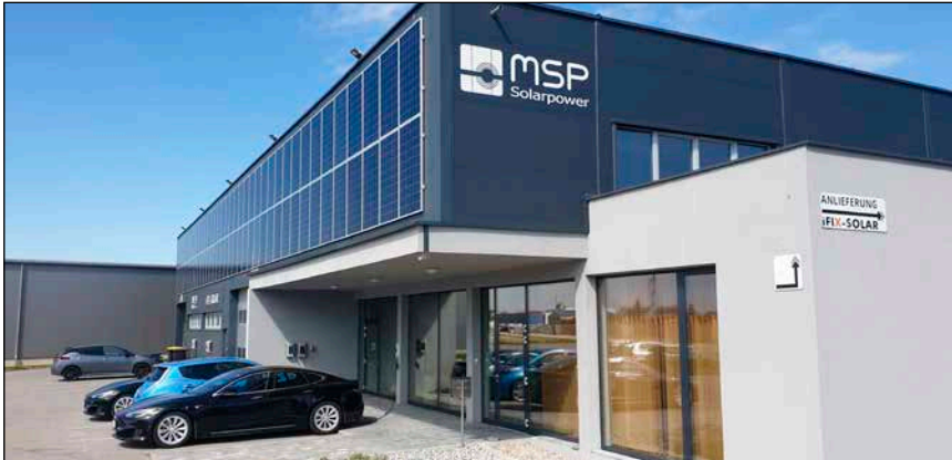
Bild 1: 180 kWp Photovoltaik und 180 kWh Speicher versorgen das Unternehmen im österreichischen Feldkirchen an der Donau, inklusive Heizung, Warmwasser, Büros, 3 Stapler und sämtliche Elektroautos, es gibt 12 Ladestationen. Damit wird 3mal mehr Energie erzeugt als benötigt. Der Überschuss wird eingespeist, soll aber in Zukunft auch alle Montageautos versorgen.
