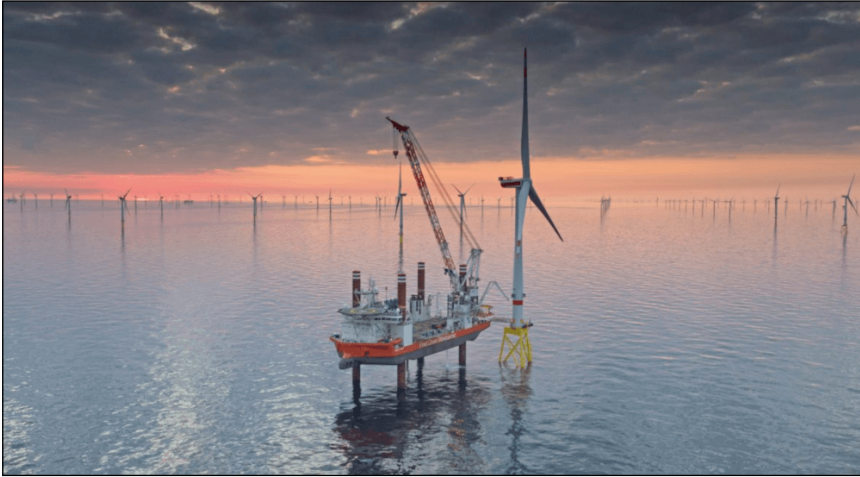
Bild 1: Windpark Borkum Riffgrund: Ein auf Stempeln aus dem Wasser gehobenes Montageschiff bei Arbeiten an einer Windkraftanlage mit Tripod-Gründung
