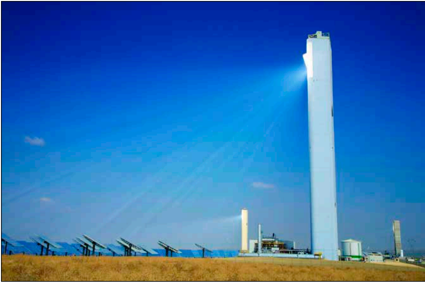
Bild 1: Bei einer CSP-Anlage wird das Sonnenlicht von Spiegeln auf einen zentralen Turm hin gebündelt, der das Licht absorbiert und damit die Wärme an einen flüssigen Energieträger im Inneren des Turms weitergibt.
