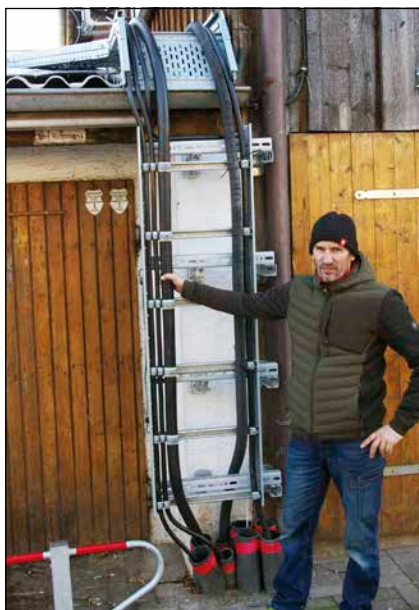
Bild 3: Verlegung der Kabel zur Ladestation über den Kuhstall
