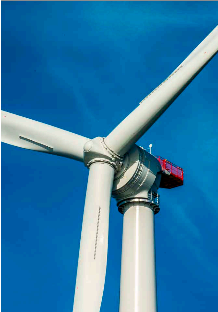
Bild 5: Rotor und Turbinenhaus einer Haliade-X, mit 12 MW die derzeit leistungsstärkste Windkraftanlage der Welt.
