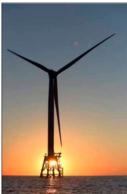
Bild 7: Eine Haliade-X auf einer Jackett-Gründung
