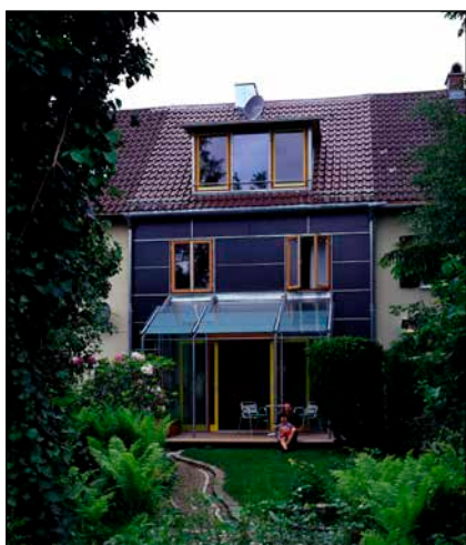
Bild 7: Eine von mehreren Einreichungen des Solar-Ästheten und Architekten Florian Lichtblau, ein grunderneuertes Reihenhaus aus dem Jahr 1958.
