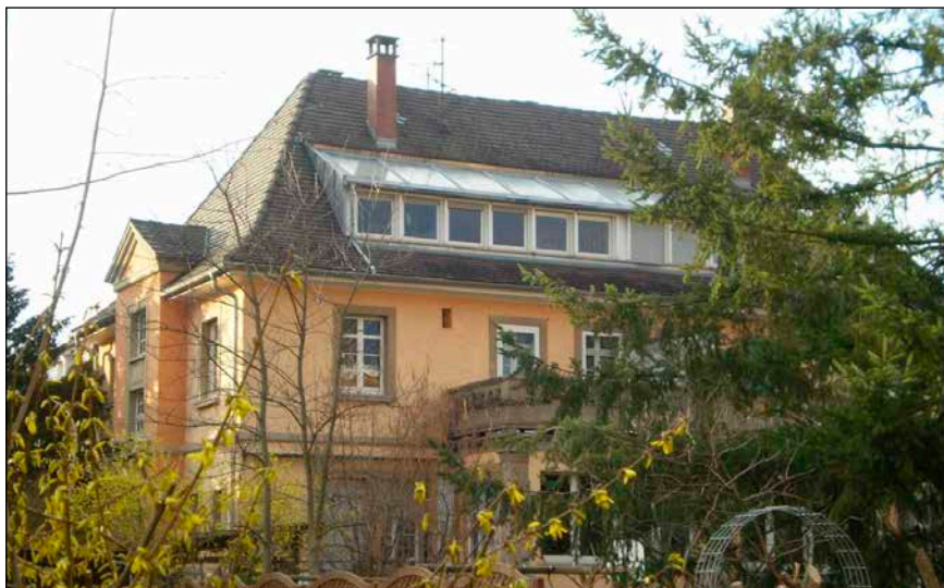
Bild 6: Die in der Dachgaube integrierten Kollektoren in Lörrach wurden mit dem Preis für die am besten integrierte Solarthermie-Anlage ausgezeichnet.
