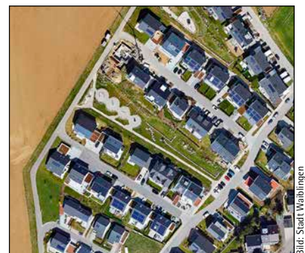
Bild 2: Neubausiedlung mit PV in Waiblingen
