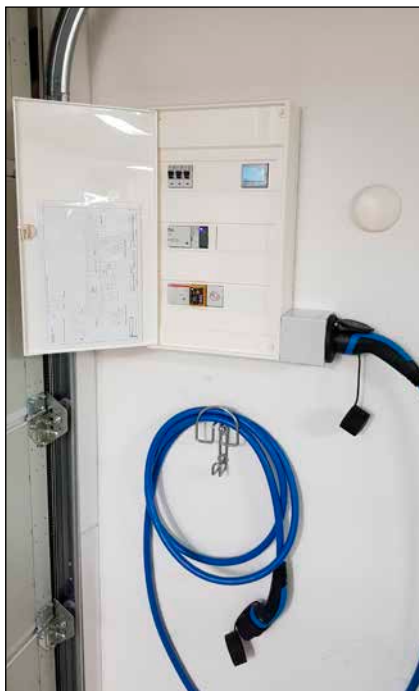
Bild 3: Duo Ladestation 11 kW, Ansicht innen
