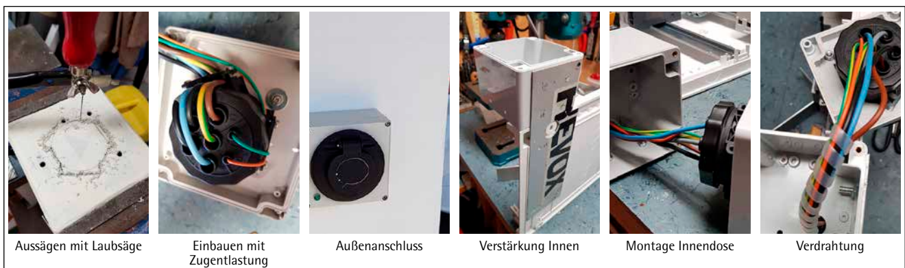
Bild 2: Montage der Steckdose
