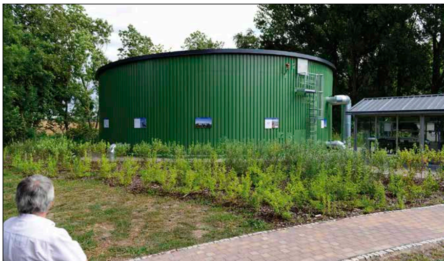
Bild 2: Wärmespeicher mit Betriebsraum
