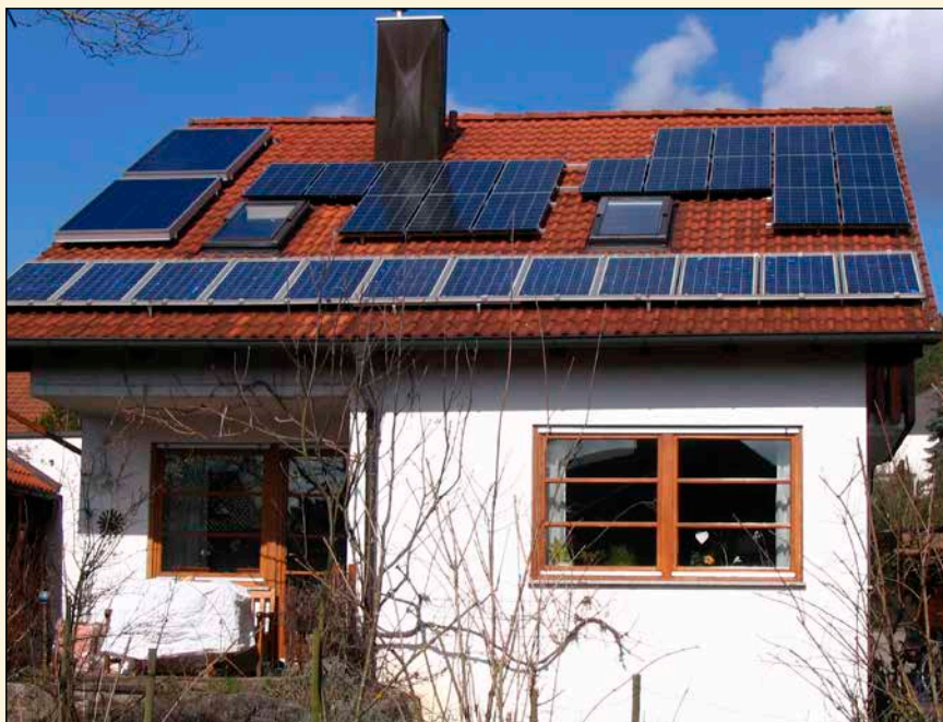
Bild 1: 1,2 kWp-Anlage aus dem Jahr 1997 (untere Modulreihe). Erweiterung (oben) stammt aus dem Jahr 2007
