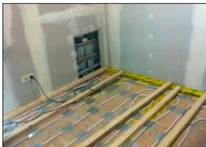
Bild 2: Einbau Fußbodenheizung auf Holzfaserverplatten als Trittschall- und Wärmedämmung gegen Keller
