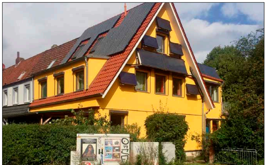
Bild 1: Süd-West-Ansicht mit Sonnenschutz vor den Fenstern: Auf dem Dach die PV-Anlage (in Westausrichtung) an der Südwand die Solarthermiekollektoren
