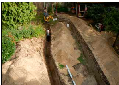
Bild 3: Rohrgraben für Wärmetauscher der Lüftungsanlage durch den Garten
