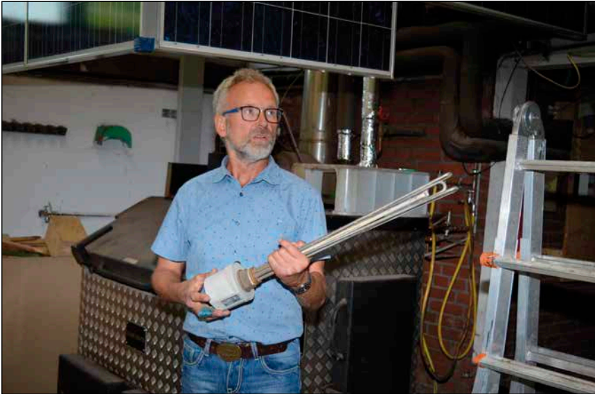
Bild 1: Mit diesen Heizstäben (9 kW) wird das Wasser in den Pufferspeichern bis auf 90 °C erhitzt.
