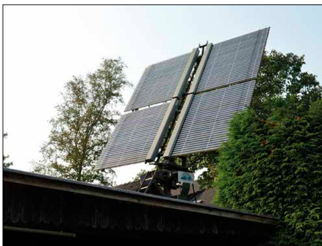
Bild 3: Der nachführbare Vakuum-Röhren-Kollektor speist die Wärme in den Heizungskreislauf ein.
