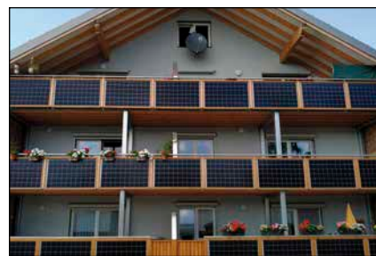
Bild 2: So geht es auch: Mehrfamilienhaus in Hamm mit vollflächig installierten Balkonmodulen (Hinweis: Auch auf den Dachflächen befinden sich noch weitere 60 kWp)
