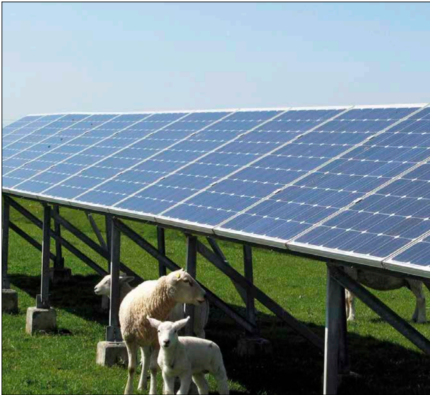
Bild 1: Agrar-Photovoltaik schon seit 1983: Doppelnutzung Solarstrom und Weideland
