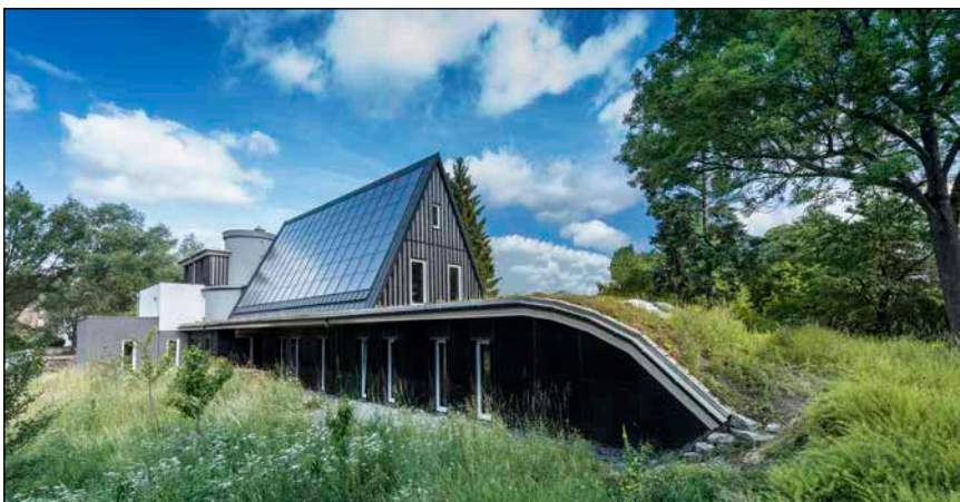
Bild 1: Die Solarthermie-Anlage ist das zentrale technische und gestalterische Element des Hofer Sonnenhauses.
