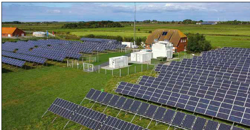
Bild 3: Blick auf das 750 kW Solarfeld während der inzwischen abgeschlossenen Forschungsphase „SmartRegion Pellworm“. In den weißen Containern waren die elektrischen Speicher untergebracht.
