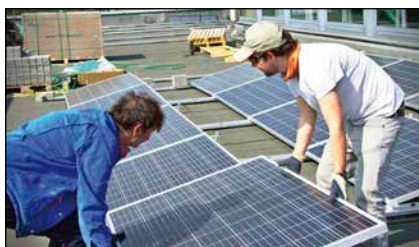
Bild 3: Selbstbau-Event der BürgerEnergie-Genossenschaft-58 rund um Hagen: fleißige Helfer*innen bei der Montage auf einem Schuldach in Iserlohn. Rechts: Benedikt Breuer aus Kassel.
