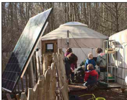
Bild 2: Kinder helfen begeistert mit bei der Installation einer kleinen Inselanlage für die Montessori-Naturgruppe Elfenwald in Kassel in einem Kooperationsprojekt mit der DGS Kassel und der regionalen cdw-Stiftung.
