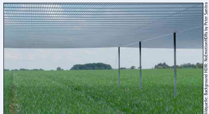
Bild 3: Die Solarröhren sind wasser- und lichtdurchlässig
