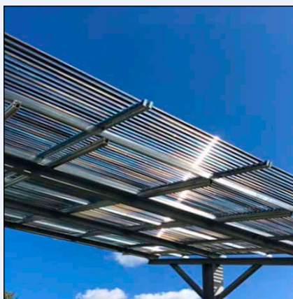
Bild 5: Neue hochstabile Aufspanntechnik aus dem Brückenbau – große Stützabstände und betonfreie Gründung
