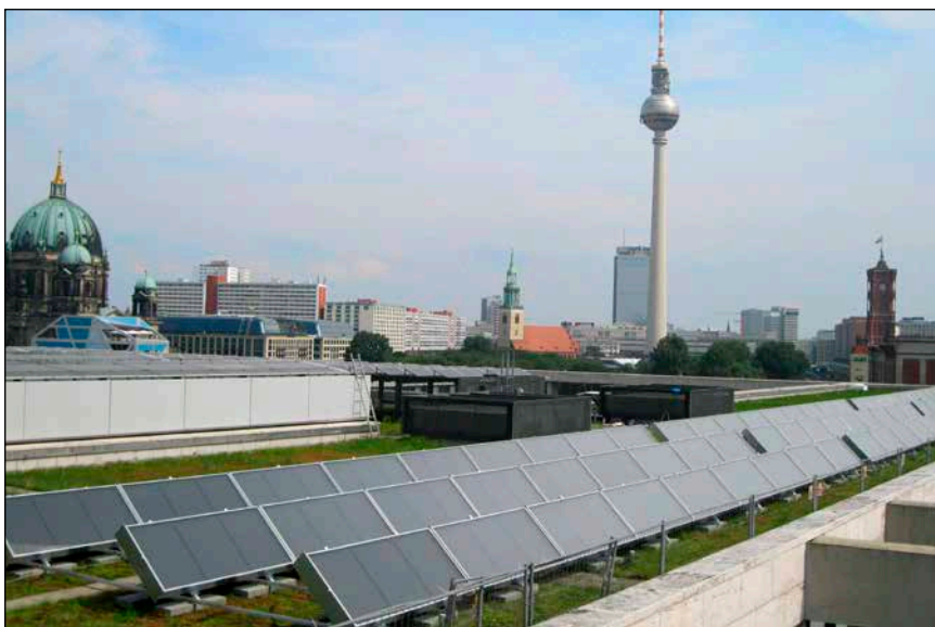
Bild 3: Solarlüftung in groß: Auf dem Auswärtigen Amt in Berlin erwärmt ein 200 m 2 großes Kollektorsystem die Luft für die Lüftungsanlage im Gebäude.
