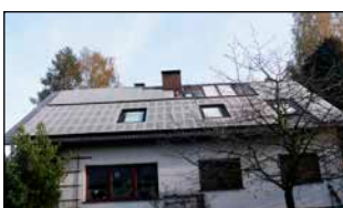
Bilder von links nach rechts: Das Dach ist voll mit PV (2 kW Solarwatt, rahmenlos + 2 Speicherkollektoren + 2 kW Mitsubishi + 5 kW AEG/ASE), Blick aus SSW; Rockwool-Platten werden palettenweise auf das Garagengradach gehoben; Besuch und Besichtigung durch interessierte Berufsschüler vor der energetischen Sanierung; 16 cm Rockwool-Platten auf der Nordseite geklebt, später noch gedübelt.
