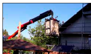
Bilder von links nach rechts: Das Dach ist voll mit PV (2 kW Solarwatt, rahmenlos + 2 Speicherkollektoren + 2 kW Mitsubishi + 5 kW AEG/ASE), Blick aus SSW; Rockwool-Platten werden palettenweise auf das Garagengradach gehoben; Besuch und Besichtigung durch interessierte Berufsschüler vor der energetischen Sanierung; 16 cm Rockwool-Platten auf der Nordseite geklebt, später noch gedübelt.
