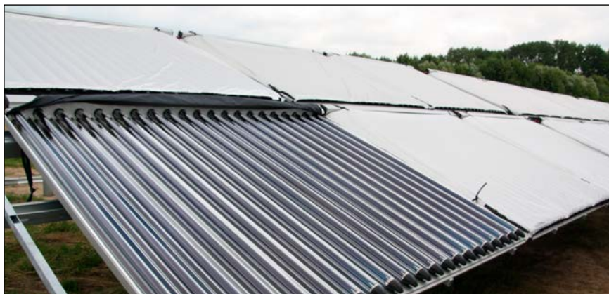
Bild 2: Bis zur Inbetriebnahme sind die Vakuu­röhrenkollektoren in Greifswald noch abgedeckt.
