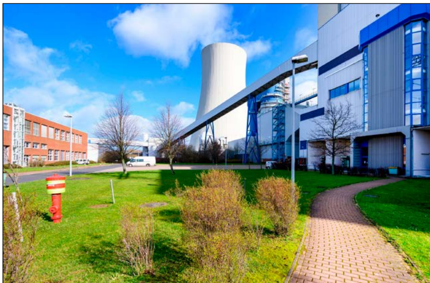
Bild: KING Kraftwerks- und Netzgesellschaft mbH, Rostock
