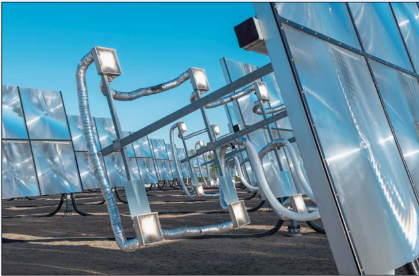
Bild 1: Solarfeld mit Fresnellinsen-Kollektoren
